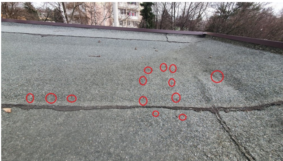
Obrázek č. 3 – vytváření boulí SBS pásu
