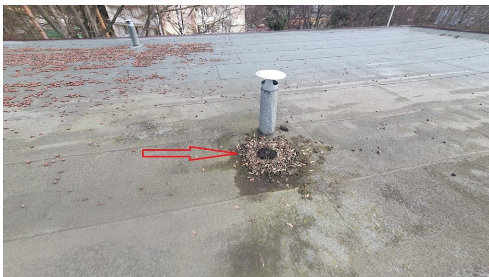
Obrázek č. 4 – zanesení střešní plochy a vpustí
