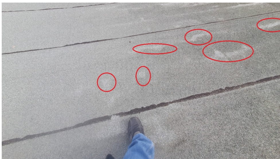
Obrázek č. 2 – degradace břídlíčného posypu SBS pásu
